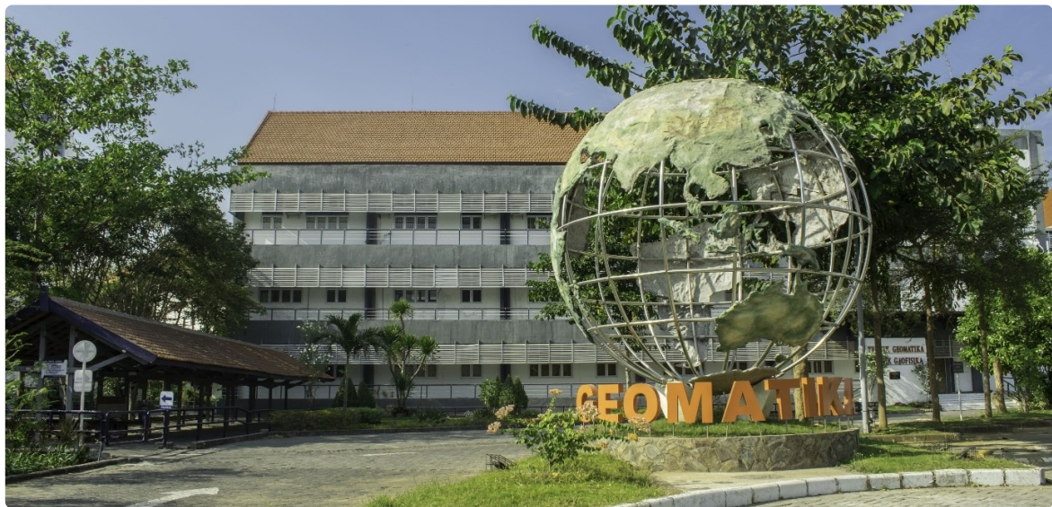
Gedung Departemen Teknik Geomatika ITS.
